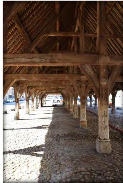
La couverture a été entièrement déposée et refaite en tuiles plates (tuiles de réemploi existantes et compléments en vieilles tuiles). Les pignons ont été restaurés (bardage bois au Nord-Est et essentage en ardoises au Sud-Ouest). La charpente a été restaurée en conservation maximale des dispositions et bois d'origine ainsi que la calade en silex (reprise des lacunes et rejointoiements ponctuels).
